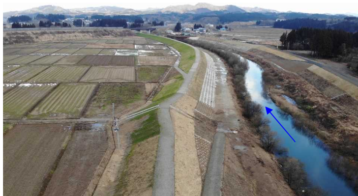
復旧工事完了
