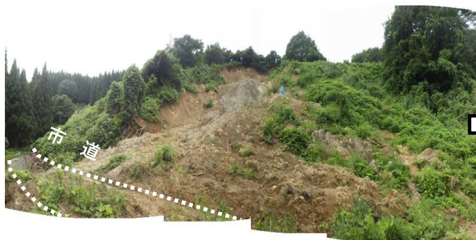
被災時(地すべりにより市道が埋塞)
