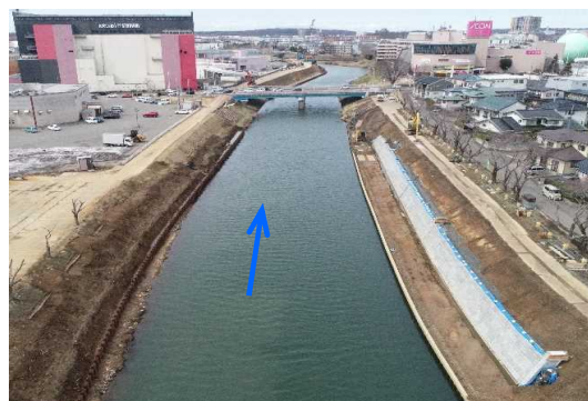
太平川(秋田市) 《河道掘削・護岸工事》
